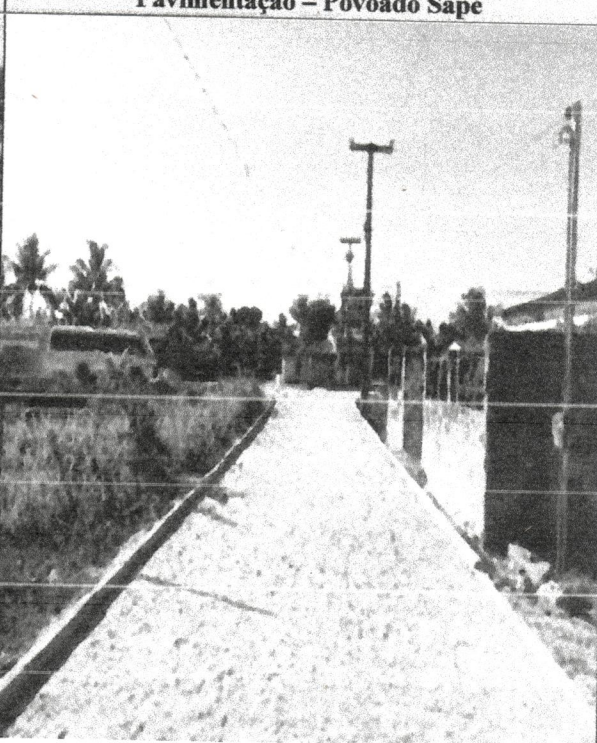
Pavimentação – Povoado Sapé
