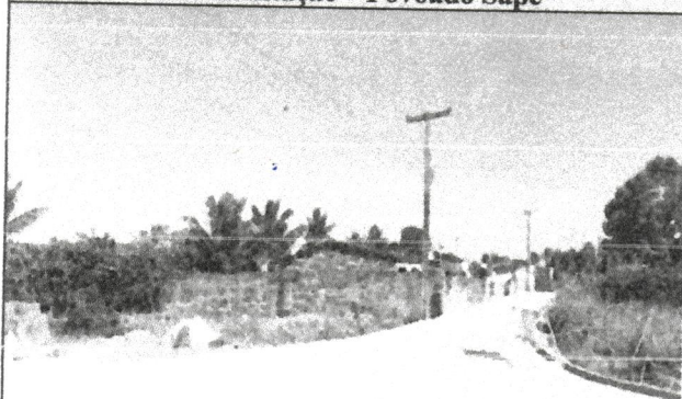
Pavimentação – Povoado Sapé
