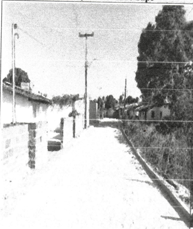
Pavimentação – Povoado Sapé
