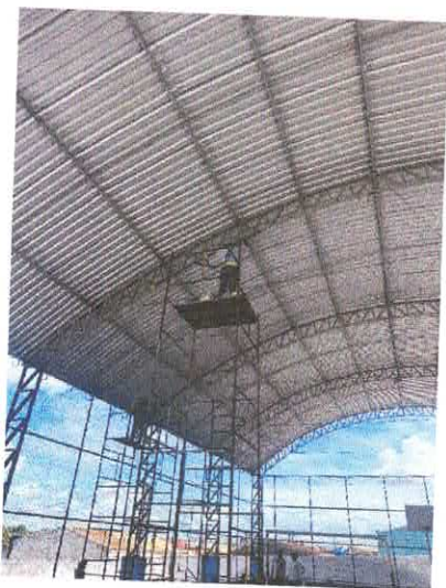
Instalação de refletor
