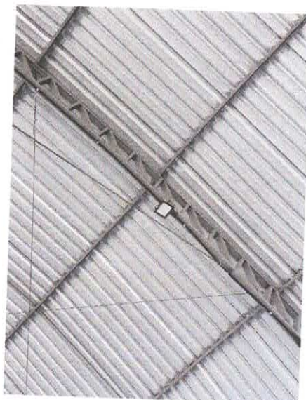
Instalação de refletor
