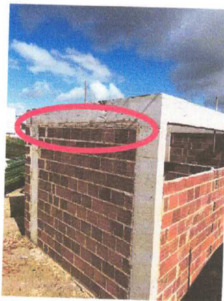
Fixação (encunhamento) de alvenaria de vedação com tijolo maciço
