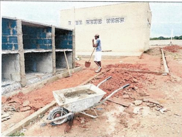
REBOCO DAS ÁREAS EXTERNAS DAS GAVETAS
