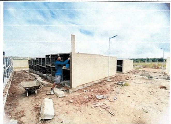
REBOCO DAS ÁREAS EXTERNAS DAS GAVETAS
