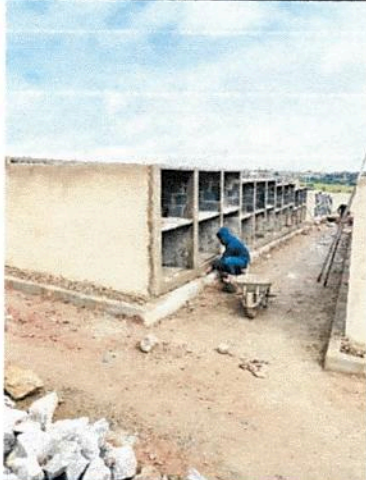
REBOCO DAS ÁREAS EXTERNAS DAS GAVETAS
