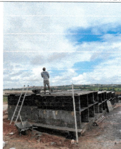
ENCHIMENTO DAS LAJES DAS GAVETAS
