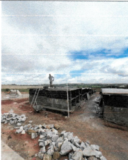
ENCHIMENTO DAS LAJES DAS GAVETAS
