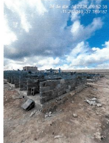
ALVENARIA DAS GAVETAS
