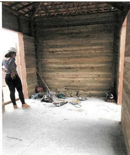
Estrutura em madeira das paredes
