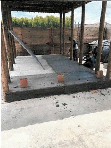
Estrutura em madeira das paredes
