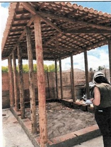
Estrutura do telhado mais início do piso
