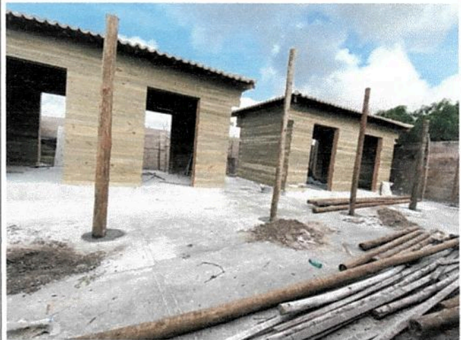
Estrutura em madeira das paredes e início da estrutura do pergolado
