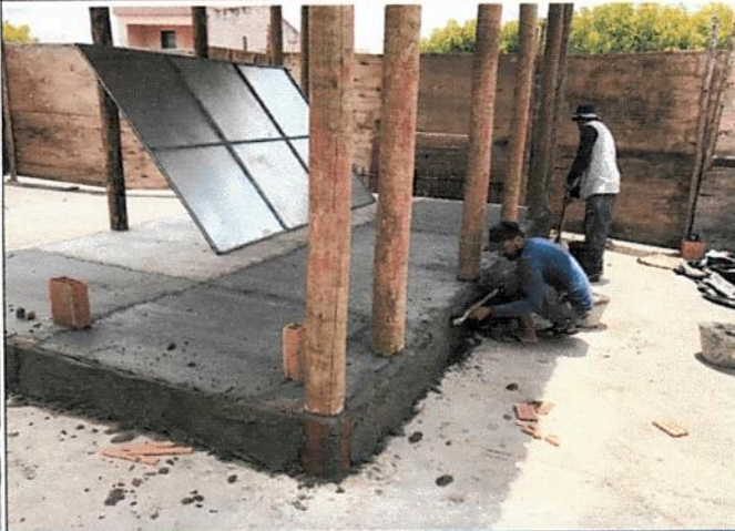
Concretagem do piso
