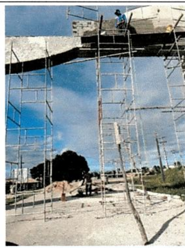
Volumes e acabamentos de viga – Via Tomar do Geru
