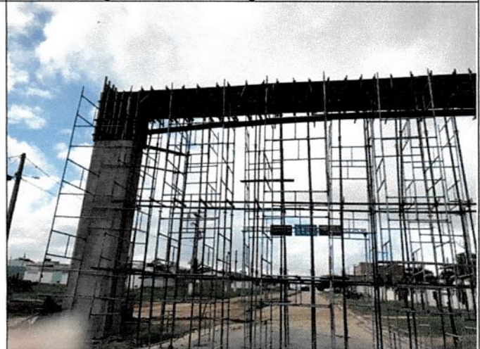
Montagem de forma da viga – via Tobias Barreto
