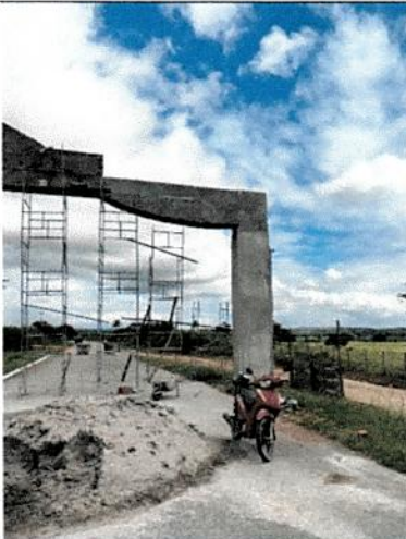
Volumes e acabamentos de viga – Via Tomar do Geru
