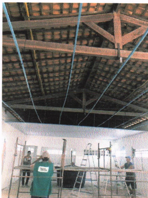
Instalação do Forro PVC
