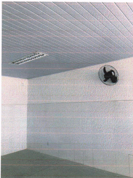
Instalação do Forro PVC, Luminárias e Ventiladores
