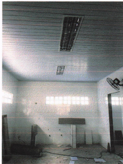
Instalação do Forro PVC, Luminárias e Ventiladores
