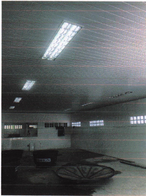
Instalação do Forro PVC, Luminárias e Ventiladores
