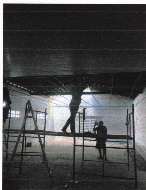
Instalação do Forro PVC
