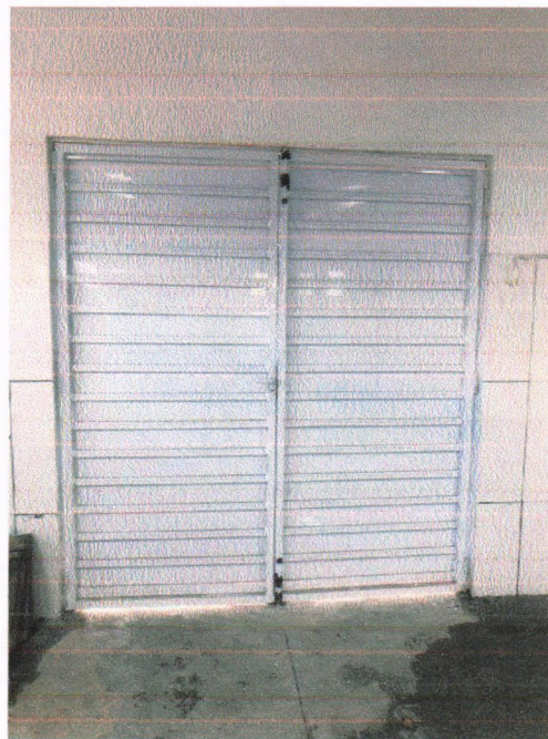
Instalação das Esquadrias
