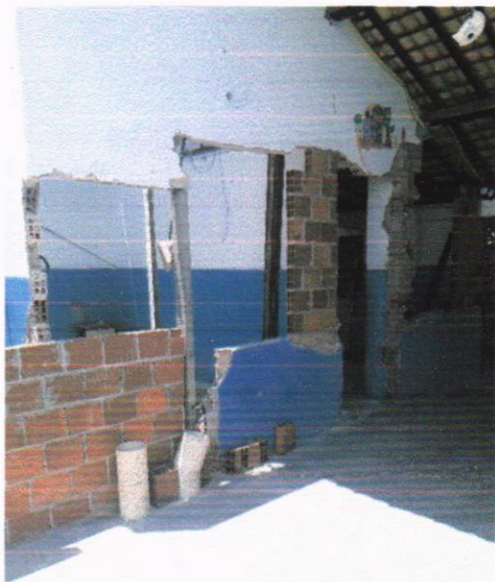
Demolição de alvenaria de Bloco Cerâmico
