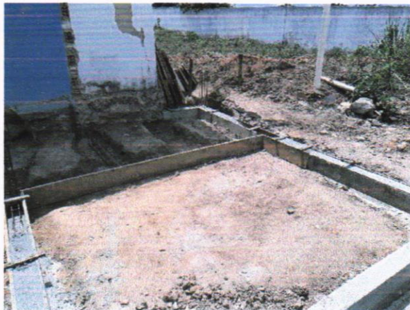
Concreto Armado – Cintamento inferior
