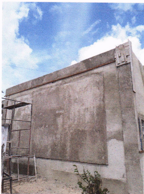
Reboco ou emboço externo
