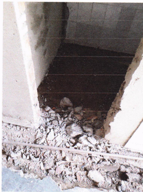
Demolições de Piso Cimentado
