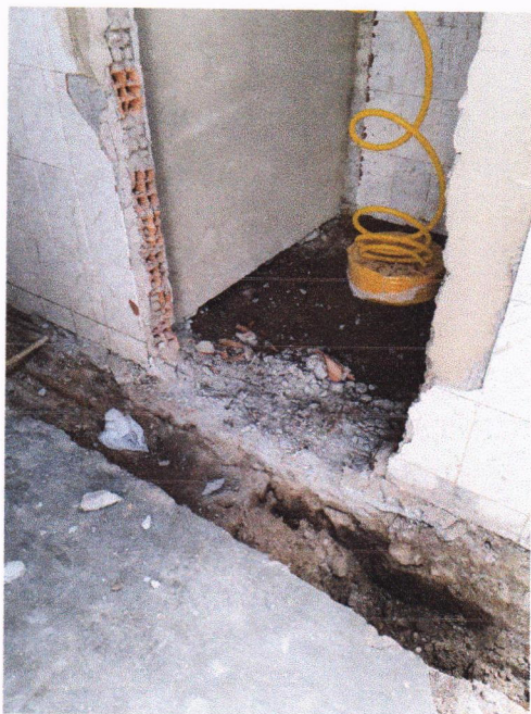
Demolições de Piso Cimentado
