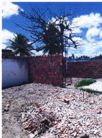
Alvenaria de bloco cerâmico
