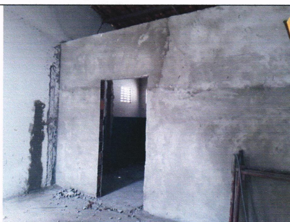
Emboço para recebimento de ceramica
