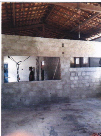
Chapisco em Parede
