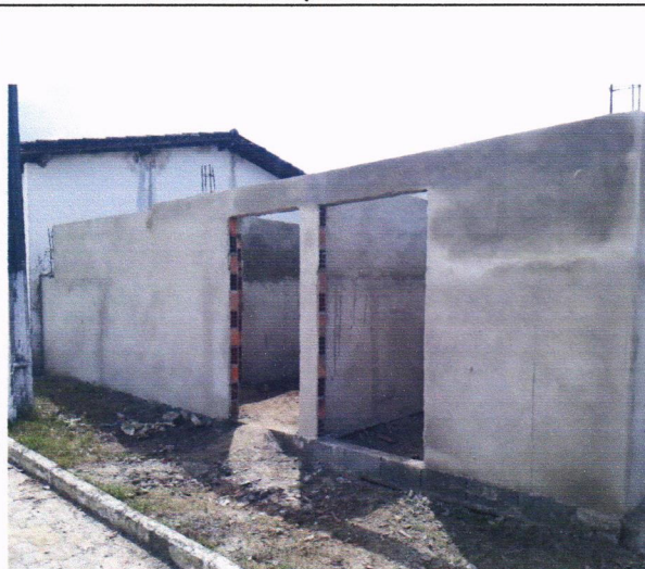
Reboco em paredes Externa
