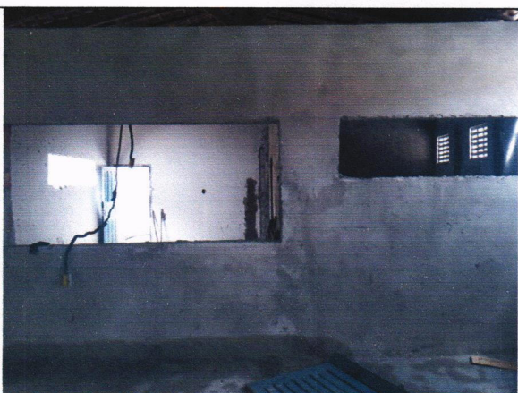
Emboço para recebimento de ceramica
