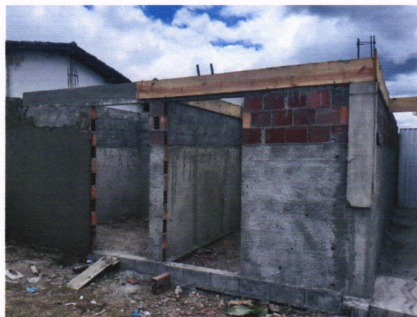
Alvenaria de bloco cerâmico
