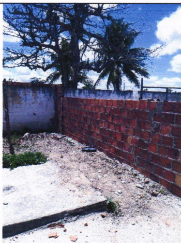
Alvenaria de bloco cerâmico
