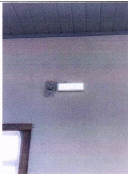
Luminárias de emergência
