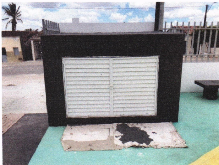
Execução de pintura em piso e bandeira
