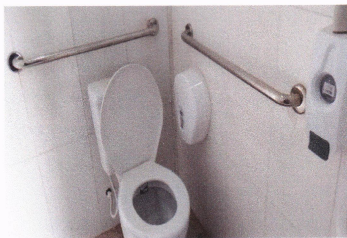
Barra de apoio em inox no wc para deficiente
