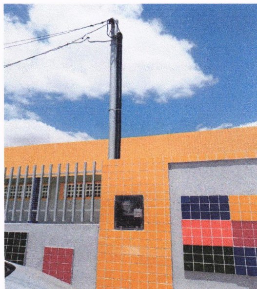
Instalação de esquadria de alumínio
