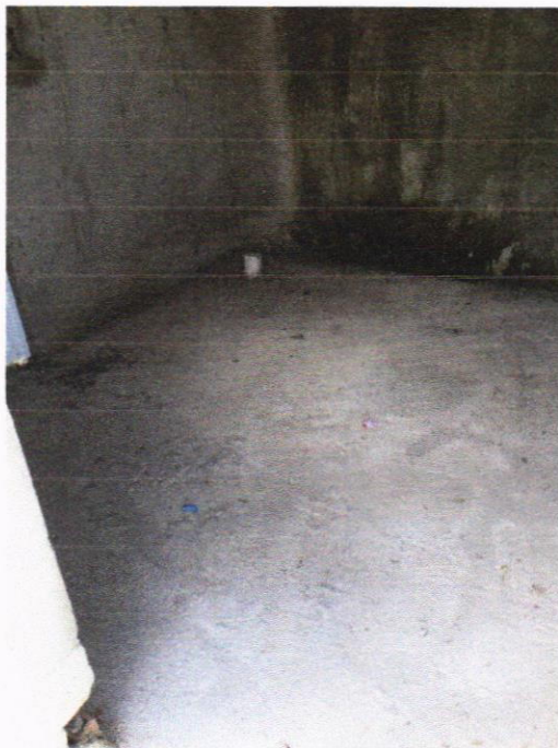
Regularização de base para Revestimento de Piso
