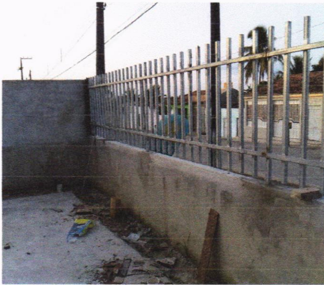
Gradil de Ferro
