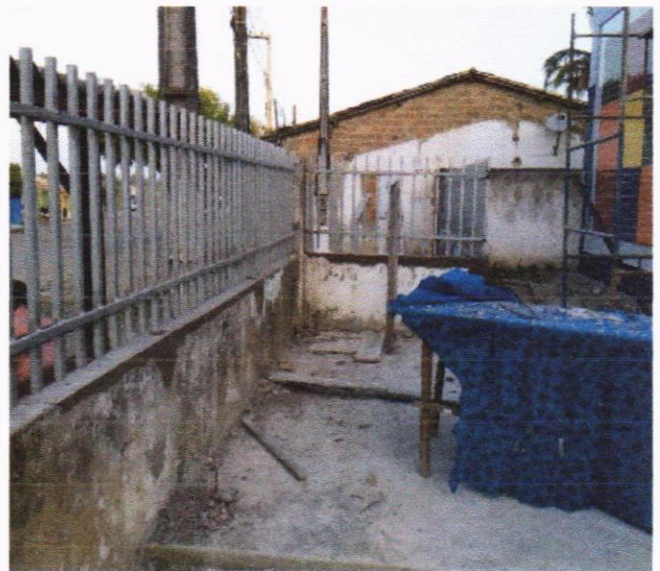
Gradil de Ferro
