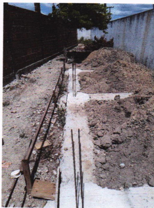
Concreto Armado – Cintamento Inferior
