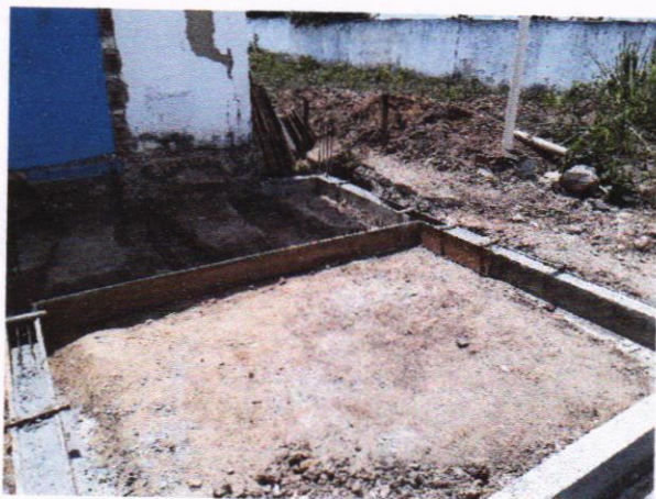
Concreto Armado – Cintamento inferior
