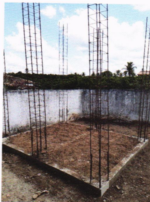
Aterro manual de valas
