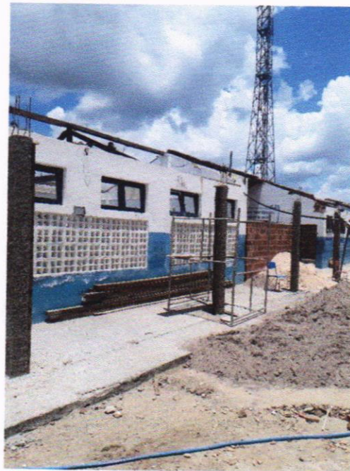
Demolição de madeiramento em cobertura com telhas cerâmicas
