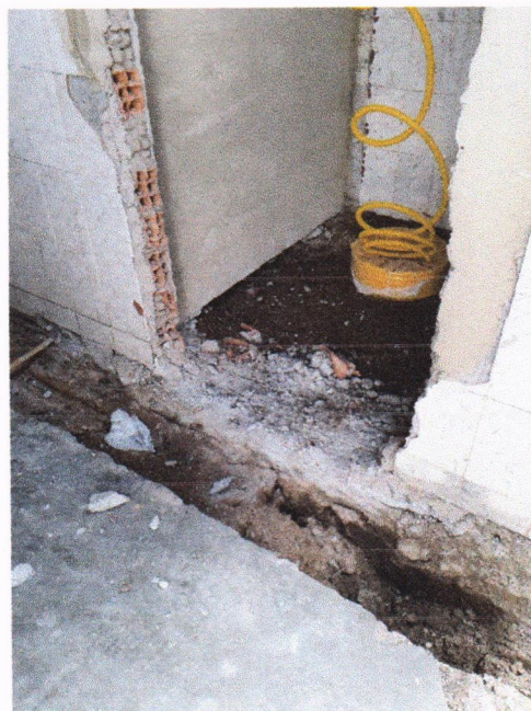
Demolição de revestimento Ceramico
