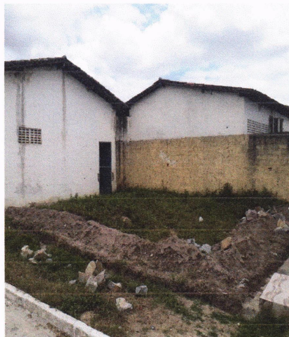
Escavação manual de vala
