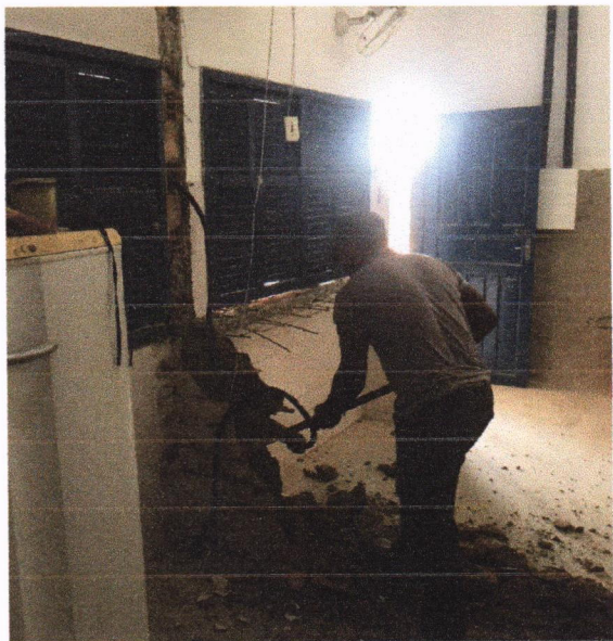
Demolição de revestimento Ceramico
