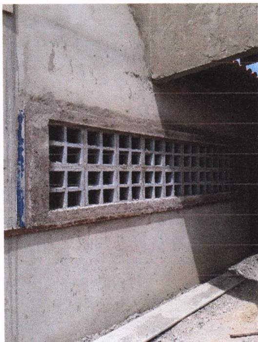
Combogo de concreto
