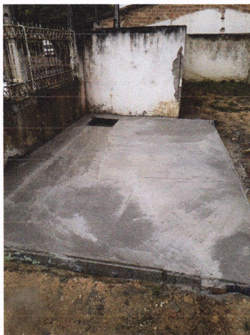
Concreto Armado Reservatorio Inferior
