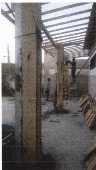
Concreto Armado Pilares
