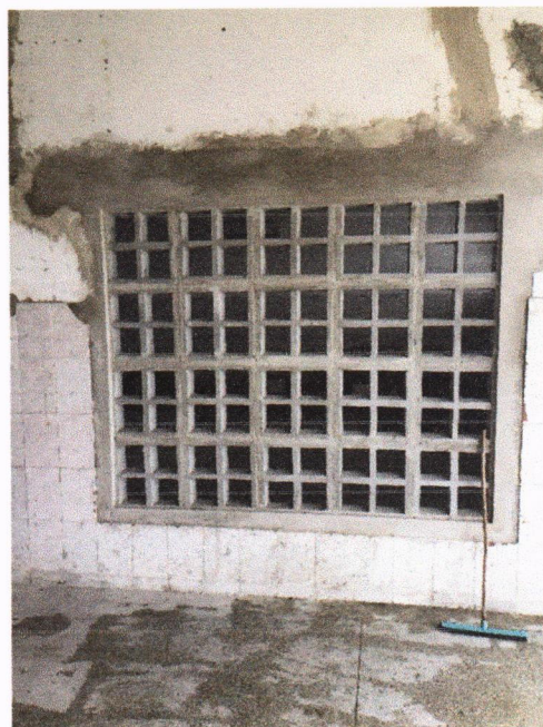
Combogo de concreto
